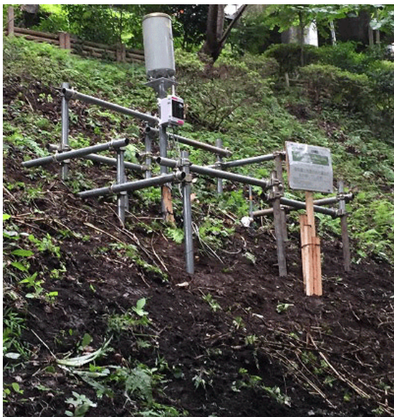
急な斜面での設置
