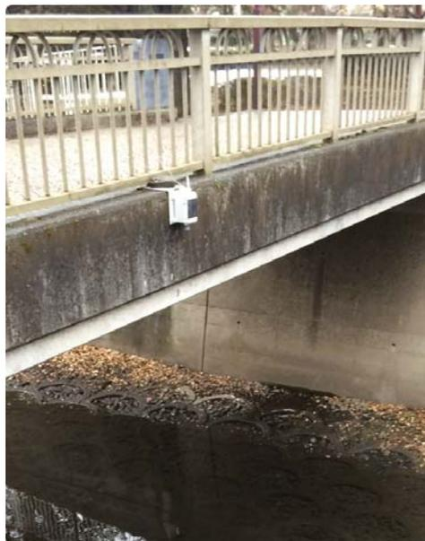
写真1 河川の橋に固定した水位観測
