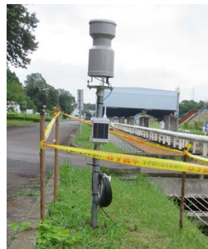
写真3 超音波センサー分離型 観測システム
